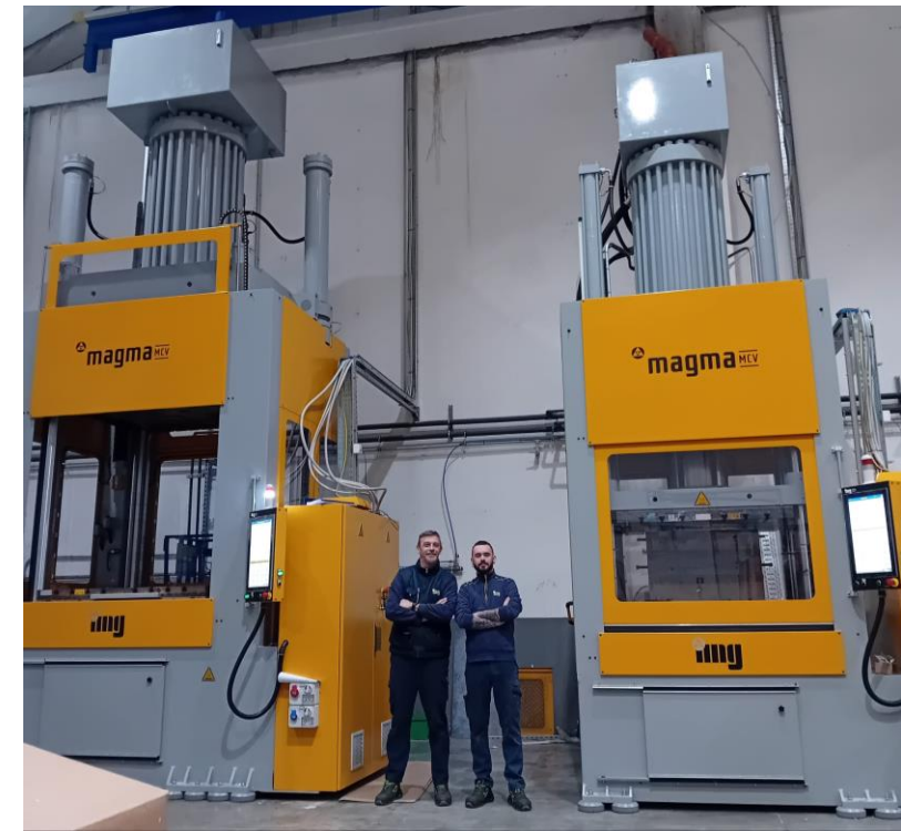
Installazione presse 5000 e 3500 kN in Bulgaria.
